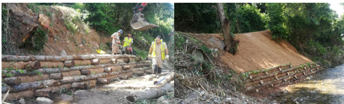
Execució d'un mur Krainer al talús del riu Mogent a Montornès del Vallès. Actuació subvencionada per l'ACA (SV17000630). Font: Naturalea Conservació, SL
