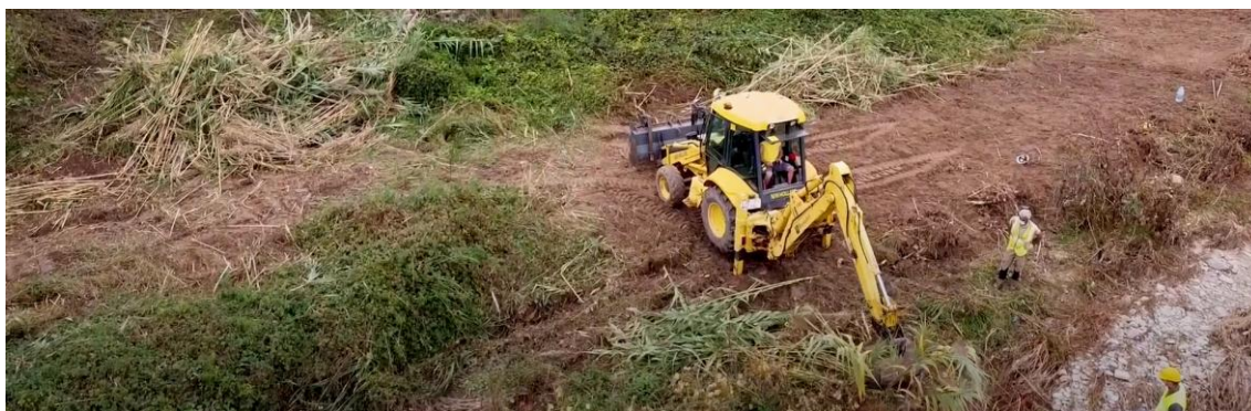
Tasques de manteniment i conservació de lleres.
