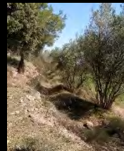
Torrent Vinyer Rases de drenatge
