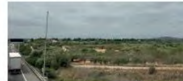
4. Vista de l'àmbit des del pont sobre l'AP7 situat a roest de l'àrea de servei.
