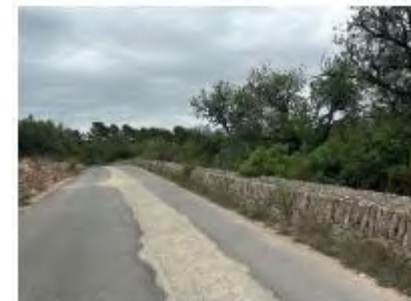
1. Vista des del camí del Ranxero, oliveres de seca en estat d'abandonament, i massa forestal del barranc
